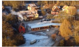
NEUES VON DER BAUSTELLE PAVILLON UPDATE
